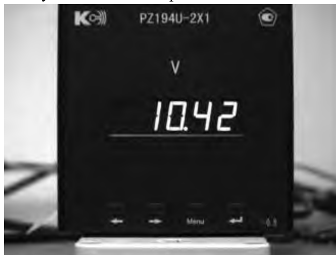
Рисунок 7 – Фотография установленного КИП в зону фиксации данных
